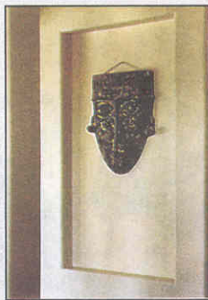
Для устройства декоративной ниши использованы скругленные профили.
